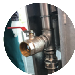
Sortie DN 50 lavage gros débit Pour lavage machine à vendanger
