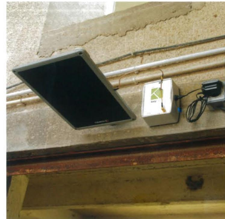
La balise fixée au-dessus de la porte du local phytosanitaire permet de suivre automatiquement les mouvements de stock.
